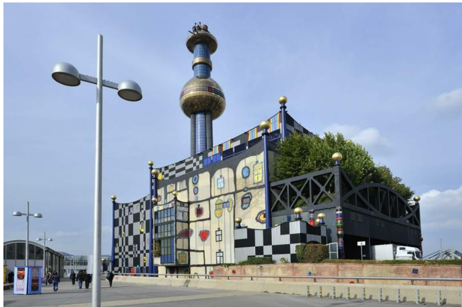
תמונה מס' 5: Spittelau Waste to Energy Plant, Vienna, Austria
